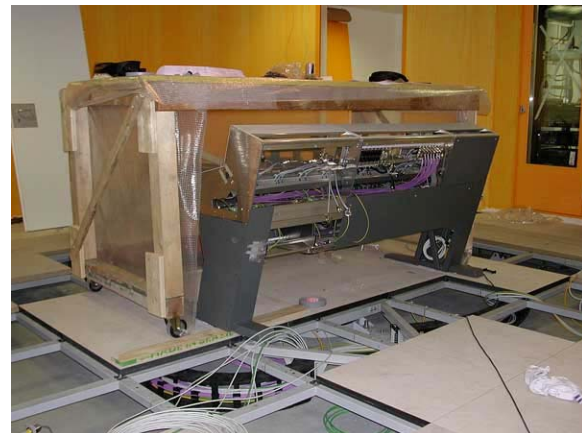
Der Regietisch wird auf der Drehscheibe positioniert.
