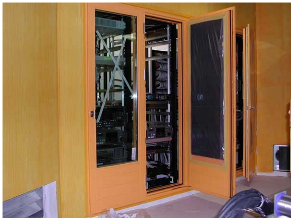
Montage der Schallschutztüren vor den Technikgestellen im Geräteraum
